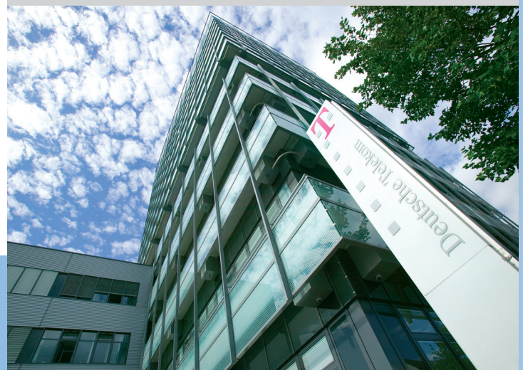
Deutsche Telekom, Frankfurt, Germany
