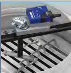
Justering av lameller med aktuator
